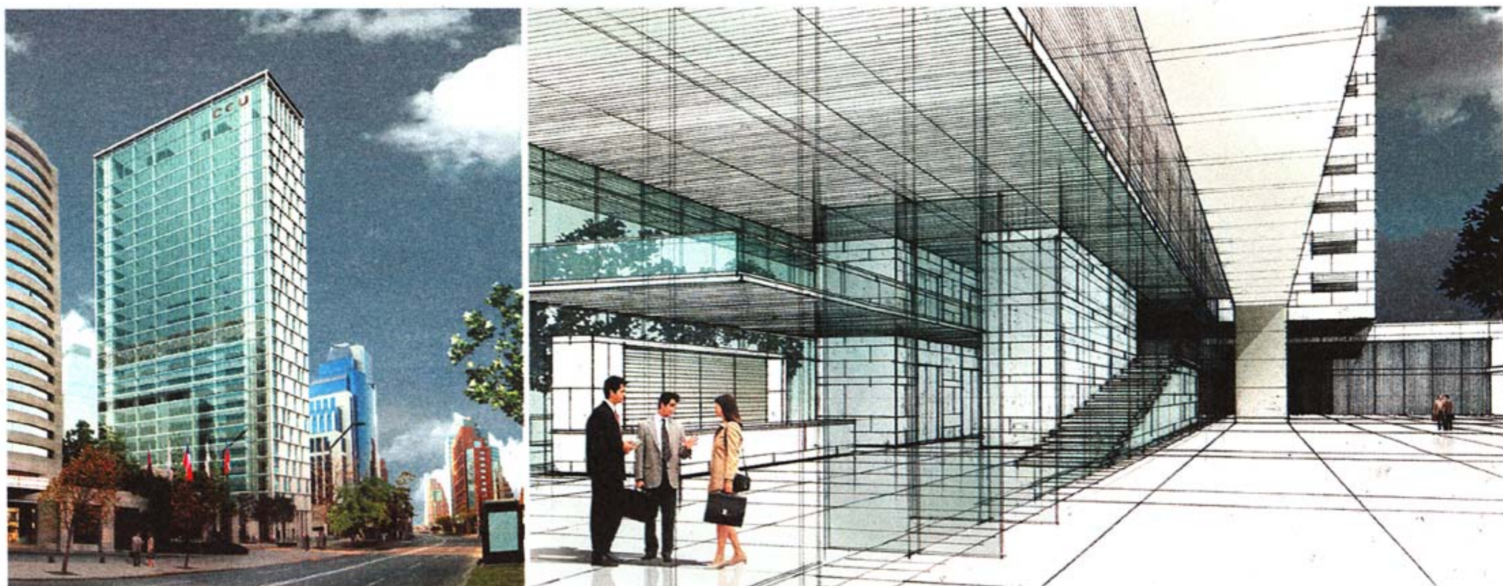
1- El emplazamiento en este sector tiene un doble objetivo: mejorar los accesos y ubicarlo en un lugar simbólico. / 2- Un ingreso lateral de triple altura —con un jardín interior— y diez modernos ascensores que optimizan los recorridos, son algunas de las características del Edificio CCU.
