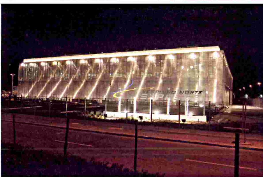
1- El patio duro se cierra gracias a una doble malla de acero, cuyas tramas generan atractivas formas. / 2- Los cuatro metros de altura de los dos niveles del Edificio Vespucio Norte Express lo destacan en su entorno.
